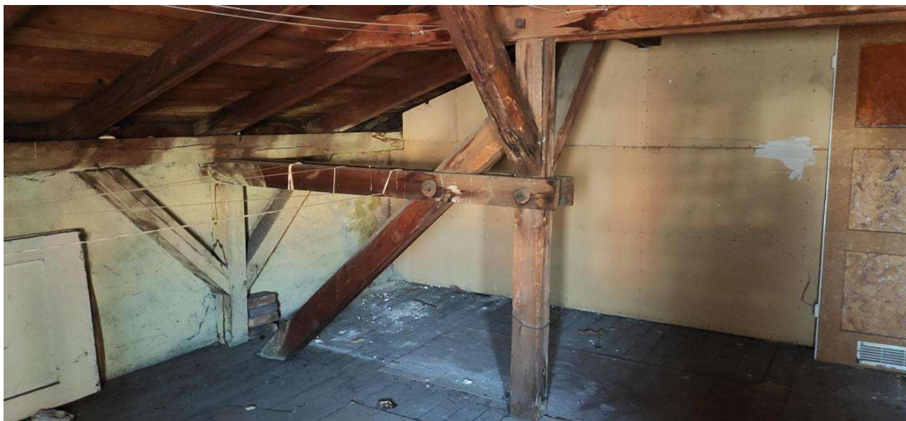
Poddasze w budynku R3 - oryginalna więźba dachowa - stan obecny. Ściany poddasza mocno zawilgocone.
