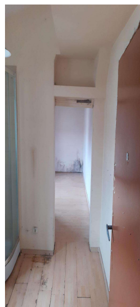
Poddasze w budynku R3 - część zaadaptowana na mieszkanie - stan obecny. Oryginalna więźba dachowa wtórnie obudowana. Ściany poddasza mocno zawilgocone.
