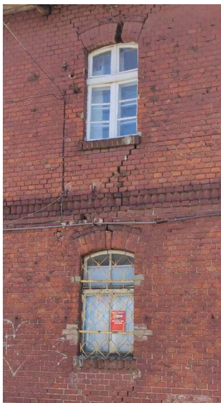
Zniszczenia i ubytki na elewacjach budynku R1 - stan obecny.
