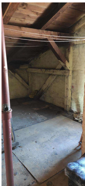
Poddasze w budynku R3 - oryginalna więźba dachowa i stolarka okienna - stan obecny.
