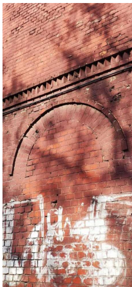
Zniszczenia i ubytki na elewacjach budynku R1 - stan obecny.
