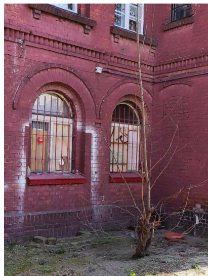
Stolarka okienna w budynku R1. Ceglane parapety oraz wykończenie z blachy wtórnie malowane - stan obecny.
