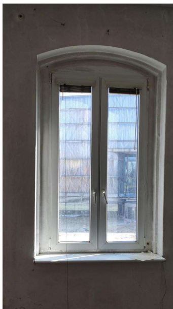
Stolarka okienna z PCV w budynku R3 – brak szprosów odzwierciedlający historyczny podział okna - stan obecny..
