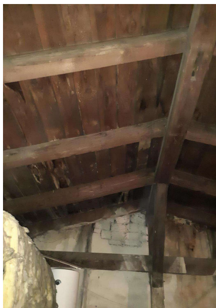
Poddasze w budynku R1. Widoczna wilgoć na ścianach - stan obecny.
